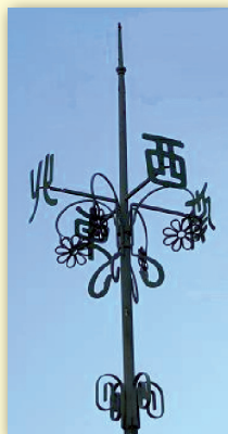
碑上部は、当時の尖塔の方位針を模擬しています。（前ページの版画参照）なお、先端は避雷針です。
