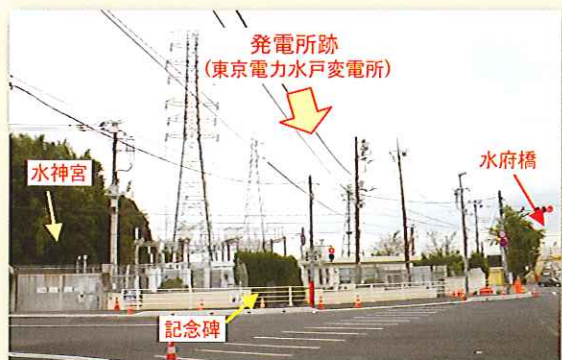
写真2 上市発電所跡 (東京電力水戸変電所) 南方向から撮影
