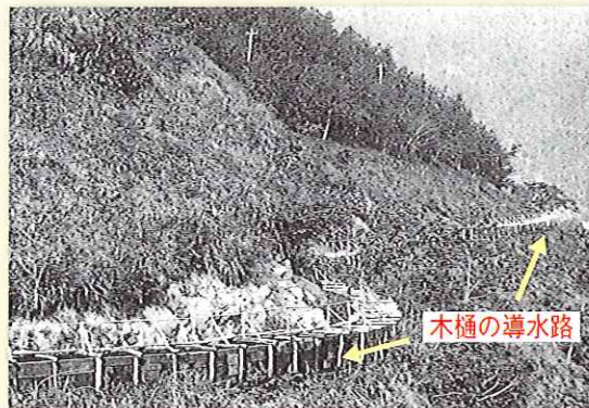
写真5 山裾を走る木樋の導水路(明治33年当初) 資料提供 岩間秀人
