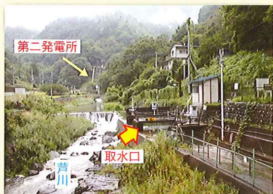
写真3 取水口と第二発電所
