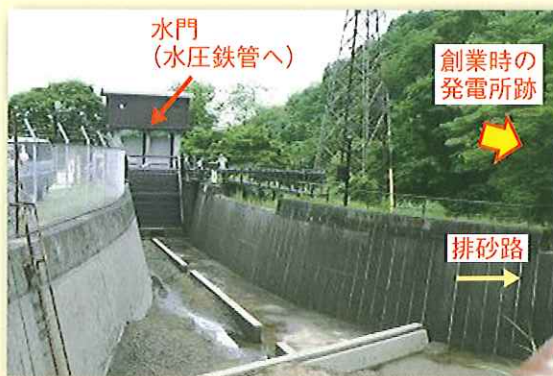
写真3 水槽と創業時の発電所跡
