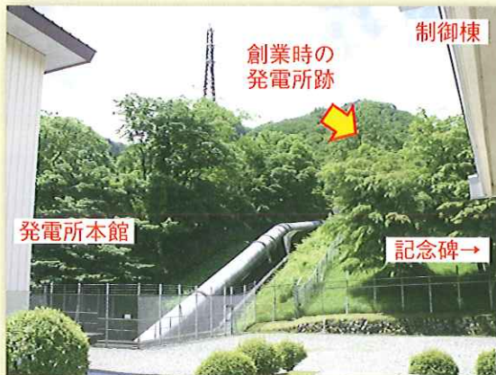
写真2 日光第二発電所
