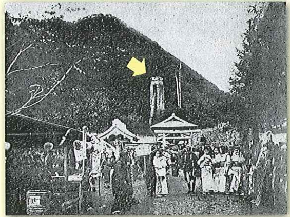
写真1 日光発電所と水神祭風景（明治後期） 山裾にある大谷石積の白いタワーから、一本の水圧鉄管が斜めに下がっています。 出典 とちぎの電力
