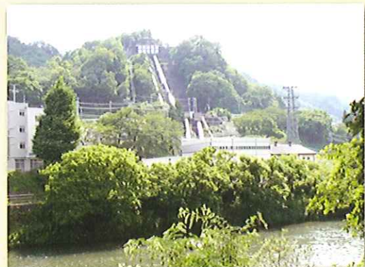
写真2 現在の駒橋発電所 ・22,200kW、発電機2台、落差103m、水量25m 3 /s ・発電に使用した水は、桂川に放水されることなく、約14km下流のハツ沢発電所へ送られています。 ・当時の遺構として、水圧鉄管のコンクリート支持台が、現水圧鉄管の右側に見られます。
