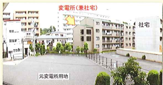
写真6 現在の早稲田変電所 (社宅の地下階)
