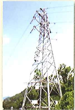
写真7 現在の鉄塔 66kV駒橋線 5号鉄塔
