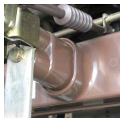
年次点検による予防保全の例（LBS 高圧交流負荷開閉器）
