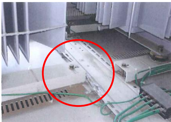
↑(栃木県足利市)【震度5強地域】病院(6kV受電、505kW、5階建屋上キュービクル) ・地震動により変圧器アンカーボルトが折損し、固定用チャンネルが破損。変圧器取付ベースが固定用チャンネルから移動し落下
