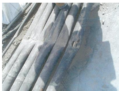
(写真1) 倒壊した煙突と潰された電線
