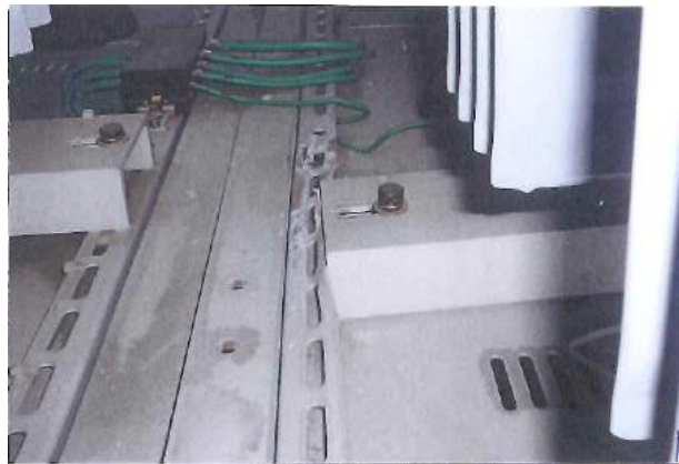
↑(栃木県足利市)【震度5強地域】病院(6kV受電、505kW、5階建屋上キュービクル) ・地震動により変圧器アンカーボルトが折損し、固定用チャンネルが破損。変圧器取付ベースが固定用チャンネルから移動し落下
