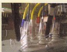
変圧器高圧充電部の防護カバー
